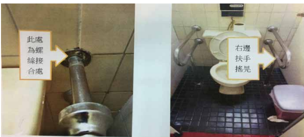
圖7 男廁現場巡檢狀況
